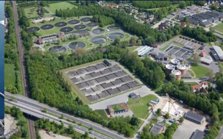
Ejby Mølle WRRF, Denmark
